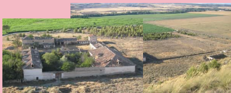
Salina de Carcavallana en la actualidad. A la izquierda, los edificios con las viviendas de los empleados en primer término y al fondo la capilla; a la derecha, el gran almacén. En la imagen de la derecha el campo de albercas y eras
